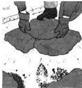
Рис. 6. Сооружение на вершине альпийской горки пирамидки из плотно уложенных друг к другу камней.
