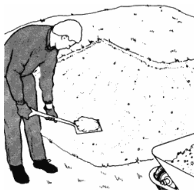
Рис. 2. Снятие верхнего плодородного слоя почвы.
